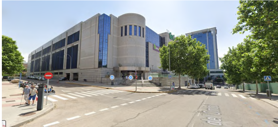
Vista desde la calle del Ombú
