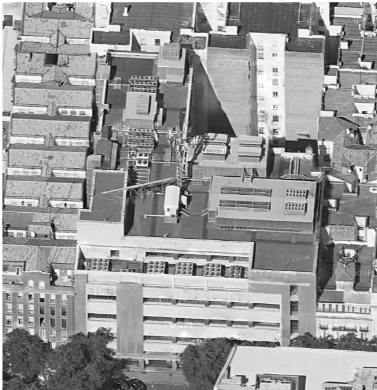
Figura 1: Estado actual. Vista aérea Este desde la calle Alcántara
