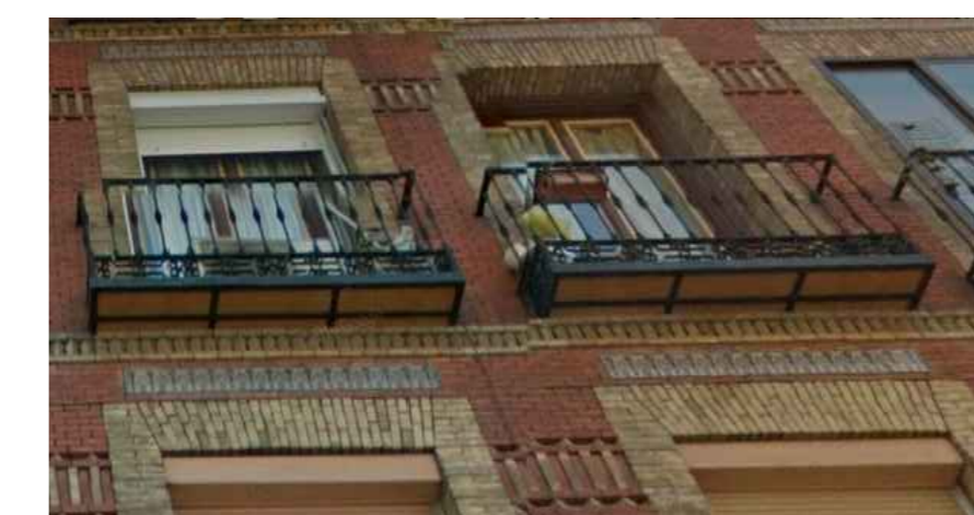
FOTO 1_ RECERCADO DECORATIVO EN HUECOS CON BALDOSA HIDRÁULICA Y CERRAJERÍA FORJA NEGRA
